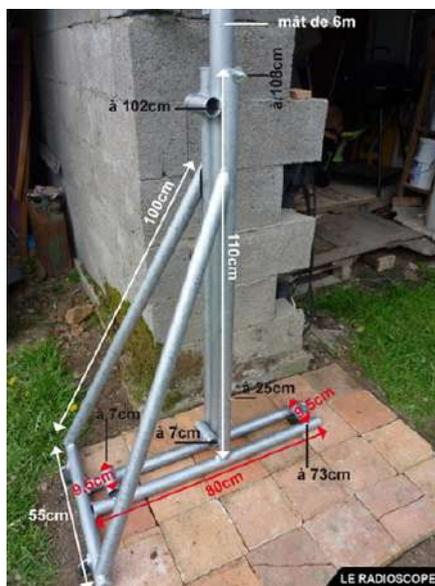
costruzione del traliccio, da unire con un tubo di 60 cm di lunghezza, di sezione inferiore. Ho determinato le dimensioni della base in funzione del volume di tubi a mia disposizione e della possibilità di far inclinare correttamente il traliccio. La base è stata costruita alta 1,15 m con l'asse del traliccio a 1,12 m da terra.
